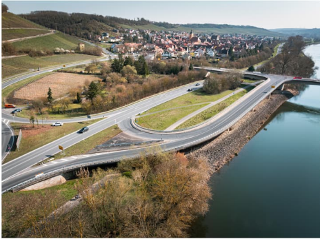
B13 mit Rampenbrücke zur Mainbrücke Sommerhausen / Winterhausen - im Hintergrund Sommerhausen
