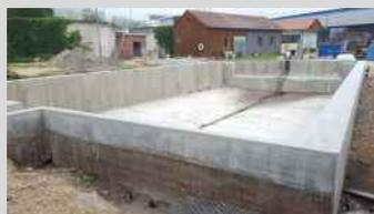
Ziel ist also, dass bei Regen über den Notüberlauf möglichst wenig ungereinigtes Abwasser direkt in die Altmühl fließt. Durch den Entfall eines der beiden Schlammstapelbehälter ist die Rückhaltekapazität für den Klärschlamm halbiert worden.
