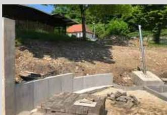
Somit ergaben sich Mehrungen von 120 m<sup>3</sup> stark durchmischten Aushubs, für dessen Ausbau und Entsorgung knapp 18.500 € fällig wurden. Zudem ergaben sich Mehrkosten für die Hangabfangung durch zusätzliche L-Steine
